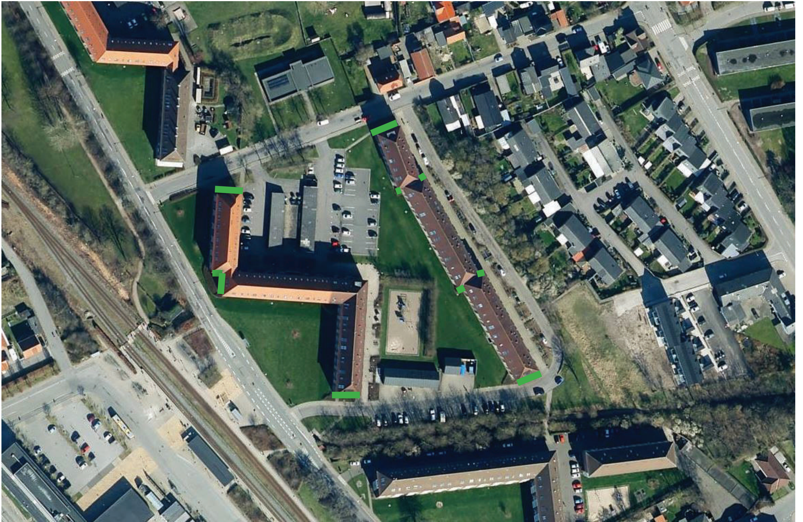
JERES GAVLE EFTERISOLERES STADIG STØTTET ARBEJDER FOR 9 MIO. KR. I ALT
