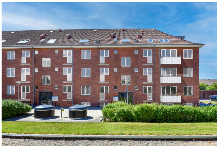
Efter renovering (eksempel)
