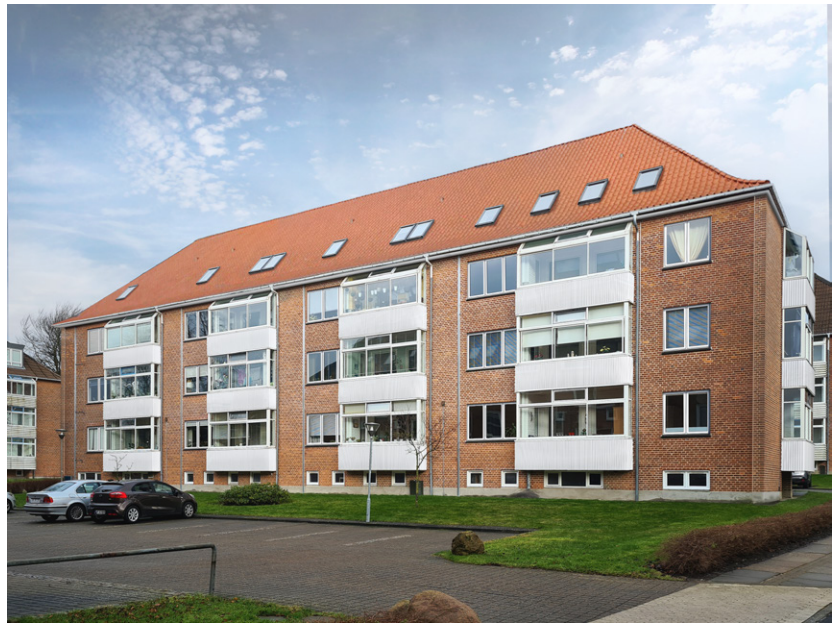
Efter renovering (eksempel)
