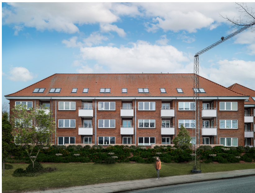
Efter renovering (eksempel)
