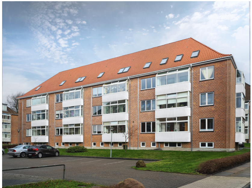
Efter renovering (eksempel)
