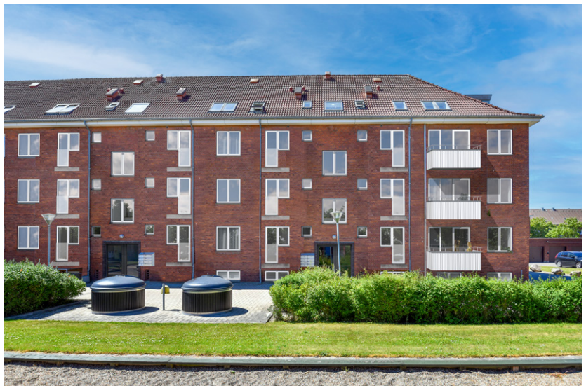
Efter renovering (eksempel)
