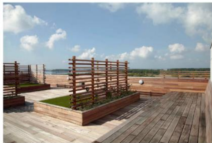
... med afsluttende tagterrasse opført i skibsplanker.
