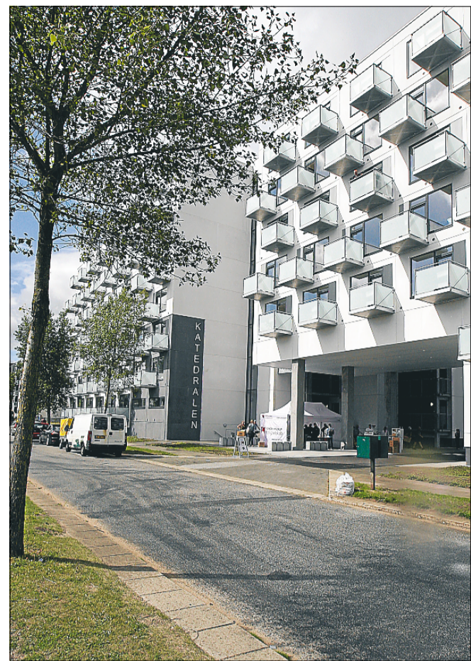
Det nye ungdomsboligkompleks på Lindholm Brygge rummer ialt 200 lejligheder. Foto: Allan Mortensen
